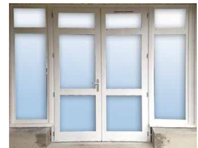
Ensemble porte et fixes avec allèges maçonnées
