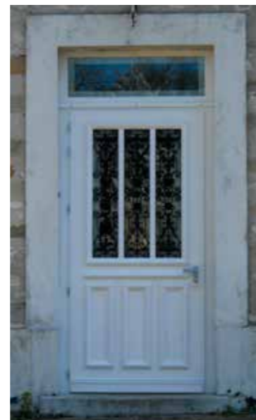
Porte d'entrée ouverture extérieure. Réutilisation des grilles
