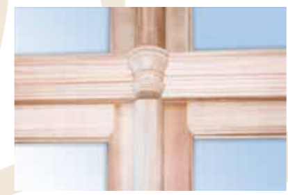
Battement demi-rond avec rappel sur la traverse d'imposte
